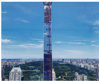
2-rasm. “111 West 57th Street” binosining umumiy ko'rinishi.
