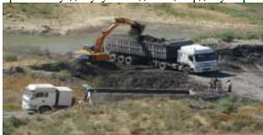
1-расм. Сурилма ҳаракатига қарши терасса қилиш учун экскаватор билан тупроқ олиш ва автомобилда ташиш ишлари жараёни
