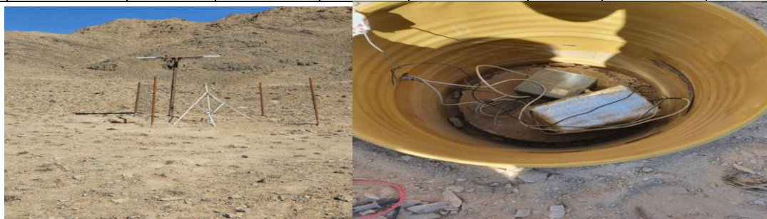
Рисунок 8. Монтаж сейсмометра и аппаратуры в камере на станции «Поселок» (MUR 2). Регистрационная возможность локальной сети.
