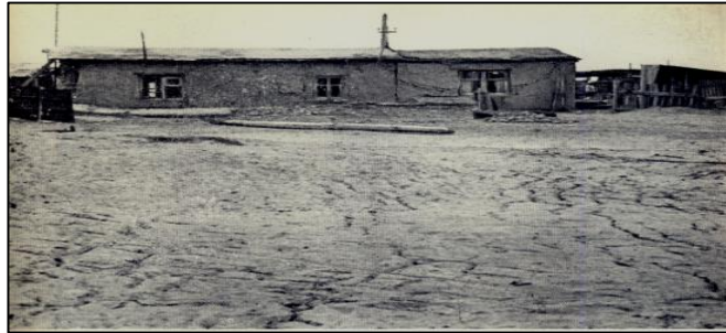
2-rasm. Quruq qumloq gruntlarda yorilishlar
