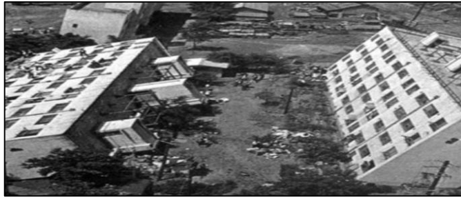
1-rasm. Grunt asosini quyqalanishi natijasida binolarning deformatsiyasi
